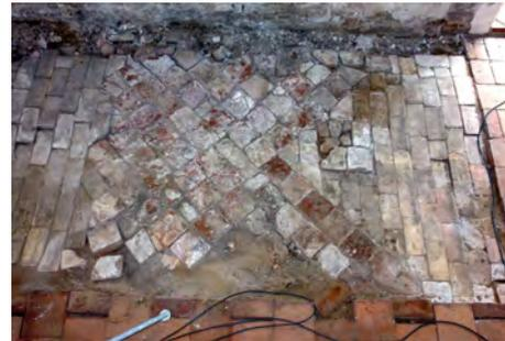
Hobeldielen, Ziegelplatten und die im Fußboden liegenden alten Kalkstein-Grabplatten wurden gereinigt und an Ort und Stelle wieder eingebaut. Die Bankquartiere (aus den 1960er Jahren) wurden nach Neulackierung und Einbau der Sitzbankheizung wieder montiert.
