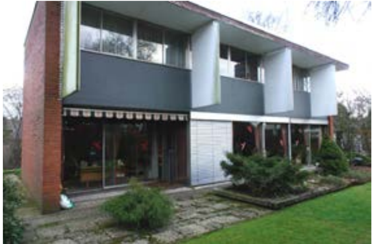
Abb. 9 Nr. 95 Gartenseite Typ C - Fenster und Putzflächen original, Markise und Sonnenschutzjalousie ergänzt
