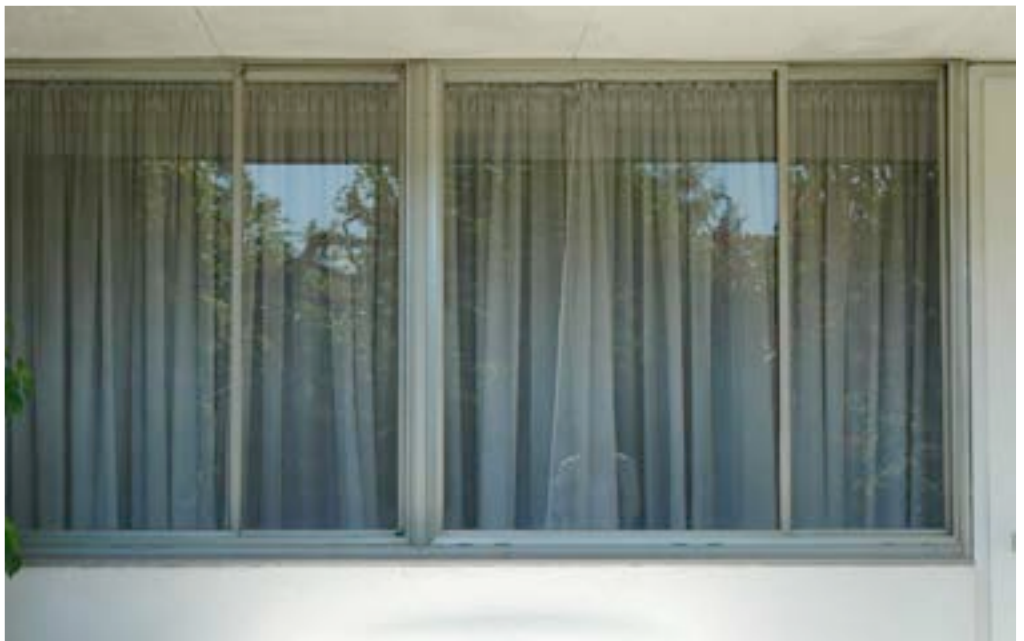
Abb. 38 Außenansicht Schiebefenster, unverändert von 1962, einfach verglast,
