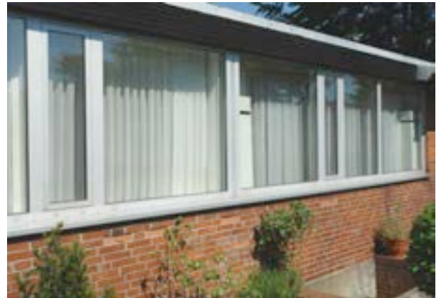
Abb. 53 schlanke, natureloxierte Alu-Fenster entsprechen dem Farbkonzept Neutras Nr. 91
