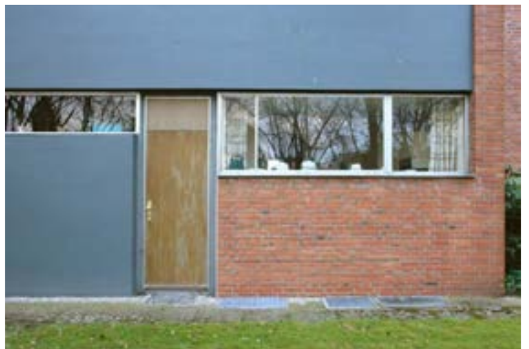
Abb. 10 Nr. 95 Typ C - Putz/Ziegelflächen, Küchentür, Schiebefenster, Oberlichter komplett unverändert
