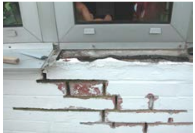
Abb. 55 Reparatur Sohlbankabdeckung Haus Goedeking, Walldorf
