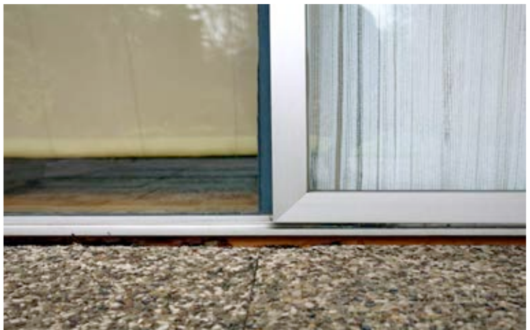
Abb. 36 Schiebetür System Hartmann "ARGOLA SV" ALU-Profil Ansichtsbreite 60 mm
