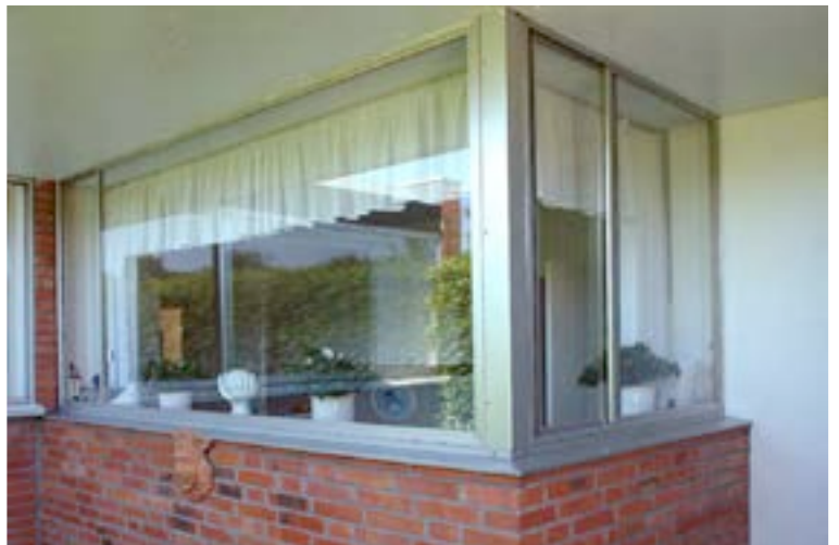
Abb. 11 Nr. 91 Typ H - Küchenerker mit Schiebefenster original
