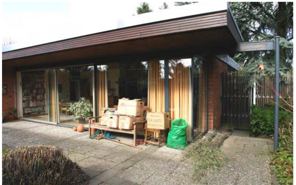
Abb. 32 Schiebetür/Festverglasung Typ H2 mit "Spyderleg", Attikaprofil verändert
