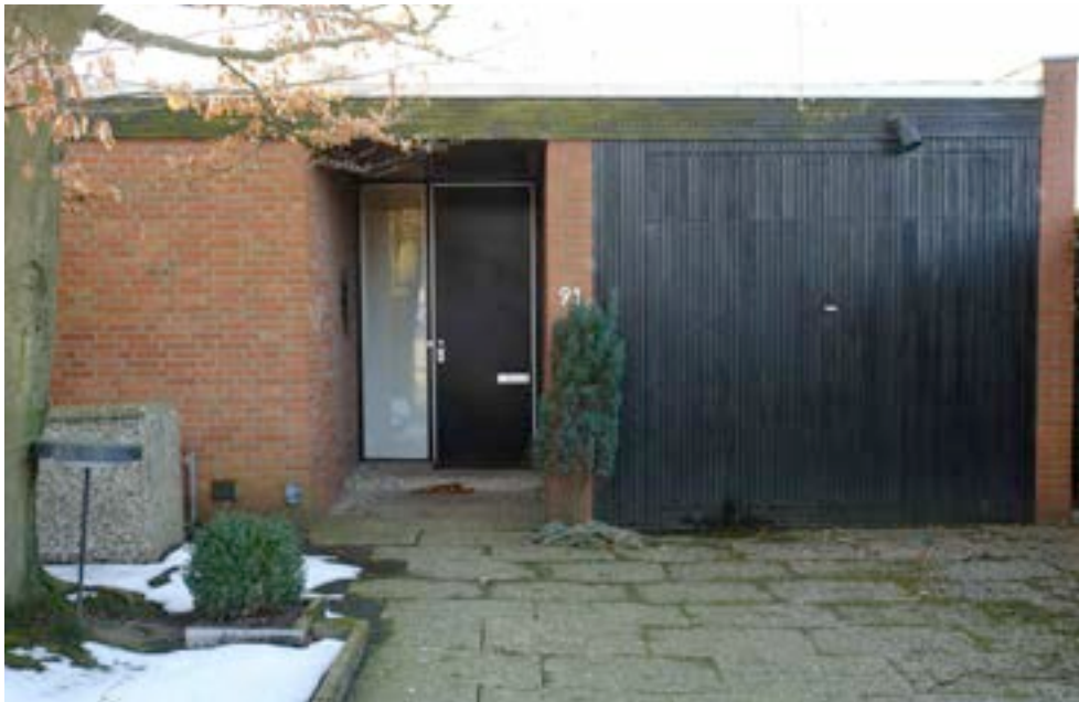
Abb. 29 Eingang / Garage mit Müllbox und Lampe Typ H
