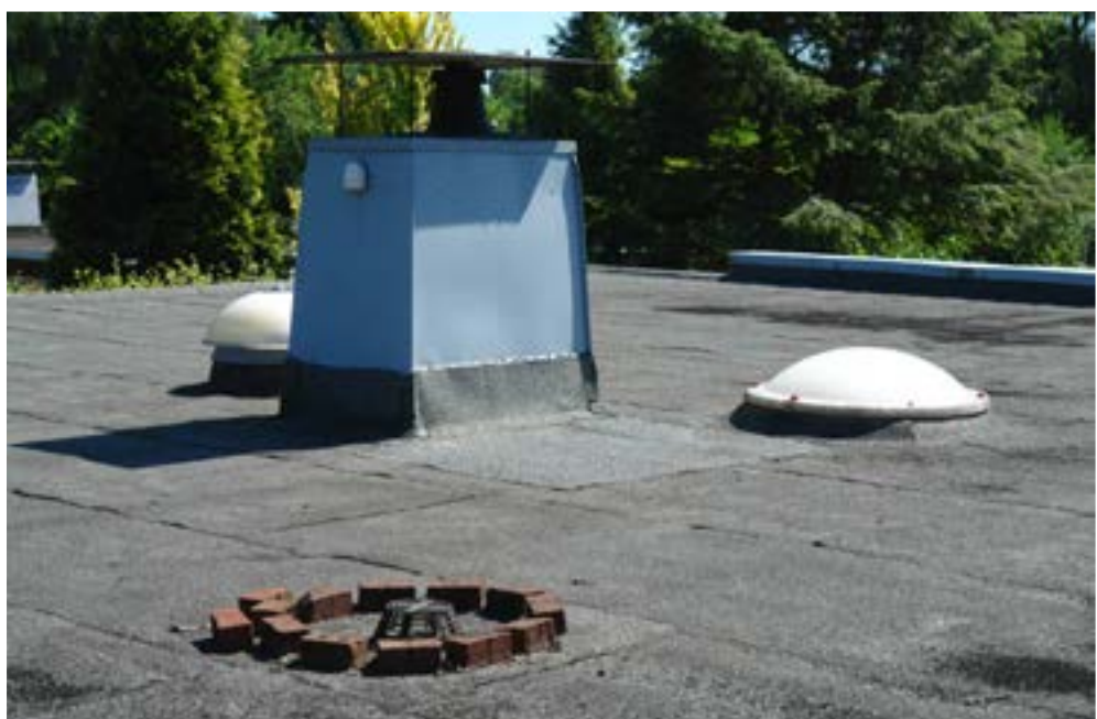
Abb. 28 Schornstein, mit Zinkblech verkleidet, später neu eingedichtet, Oberlichter, Dachgully
