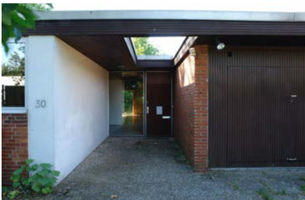
Abb. 30 Eingangsbereich Typ O mit offenem Oberlicht und teilw. Putz
