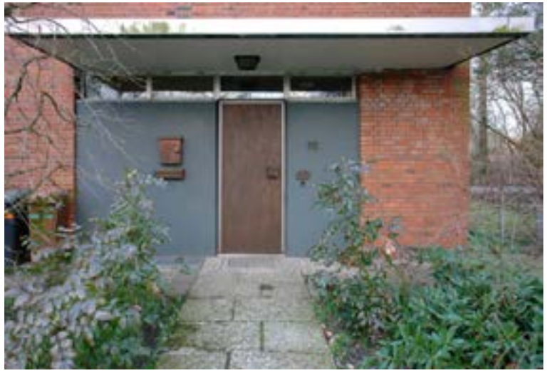
Abb. 8 Nr. 95 Eingang Typ C - Putz/Farbfassung und Oberlichter original, Türblatt/Briefkasten verändert
