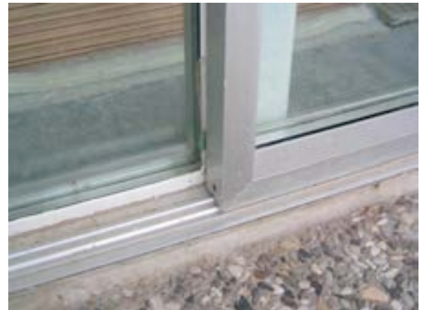
Abb. 51 Neuverglasung u-Wert < 1,1 \text{ W/m}^2\text{K} Haus Mehrfeld, Walldorf
