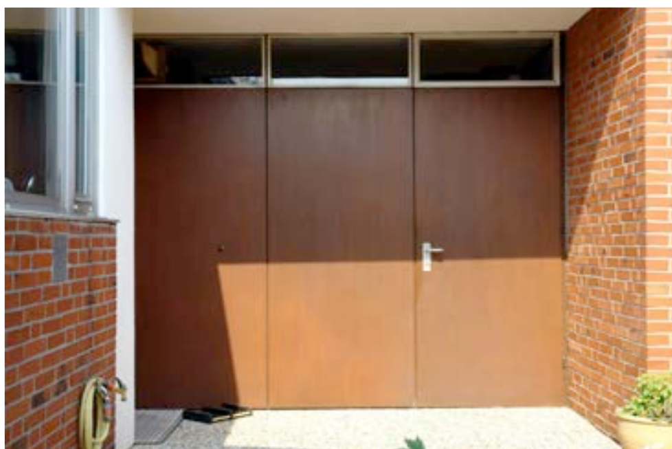
Abb. 31 Garage Gartenseite - Mahagoni-Elemente mit Oberlichtern und Tür
