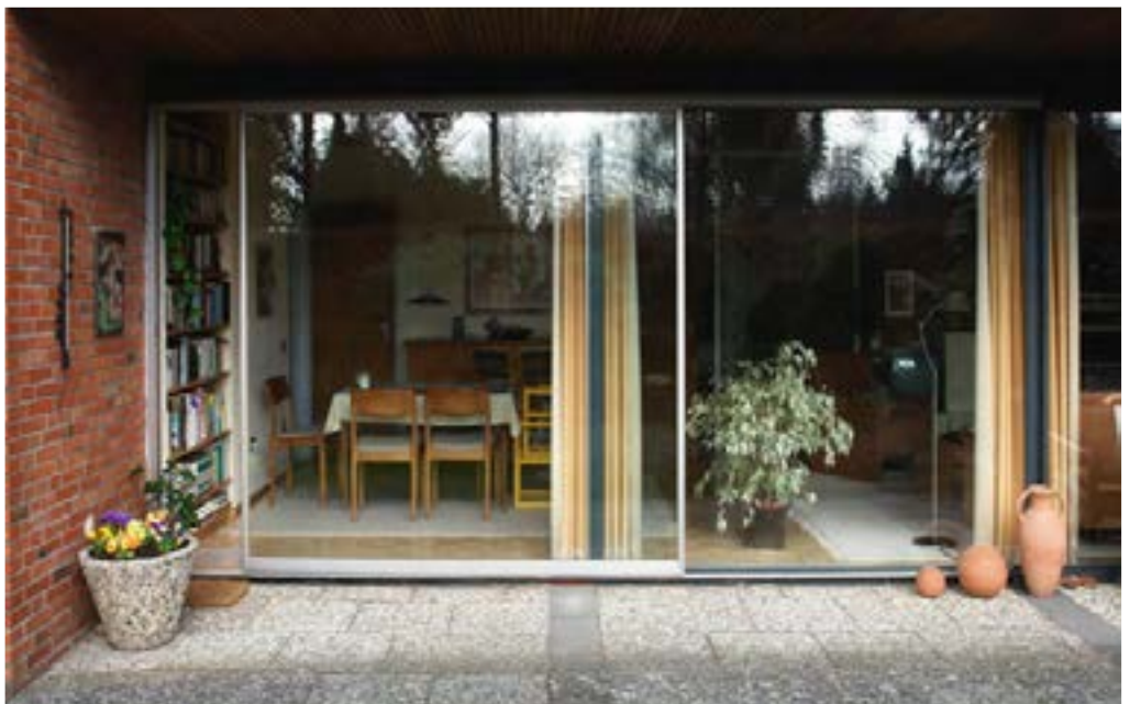
Abb. 33 Schiebetür Original - ALU-Profil Ansichtsbreite 30 mm, unten gedoppelt
