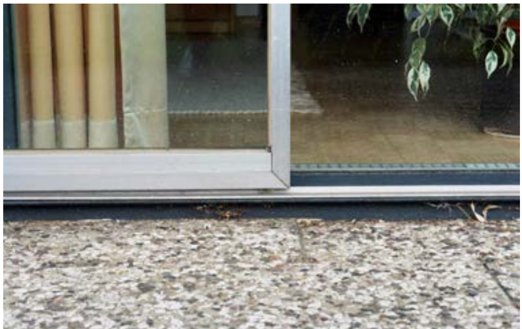
Abb. 34 ALU-Profil unten gedoppelt, alte Thermopene-Scheibe u-Wert = 3,2 W/m 2 K
