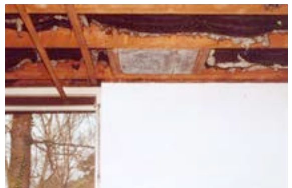
Abb. 59 Deckendurchgang für Schornstein im Wohnraum
