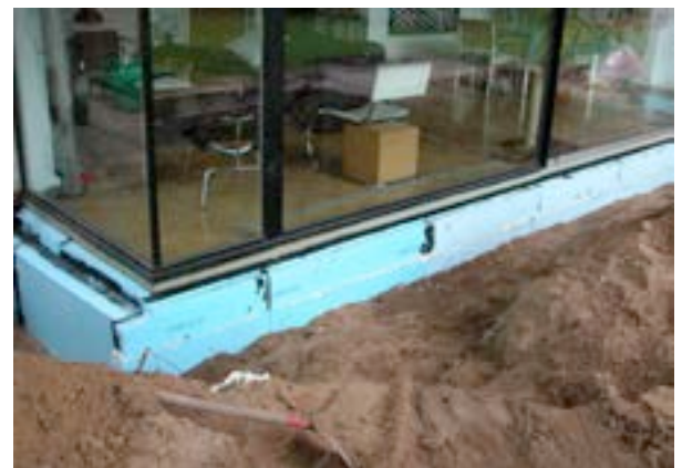
Abb. 52 Perimeterdämmung im Bereich der Kellerdecke Haus Goedeking, Walldorf
