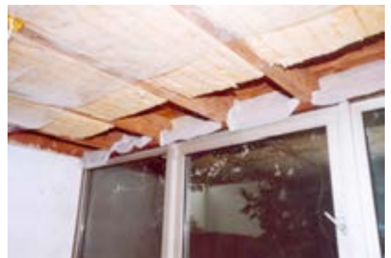
Abb. 49/50 Einbau einer neuen Wärmedämmung als Vollsparrendämmung mit luftdicht abschließender Dampfsperre
