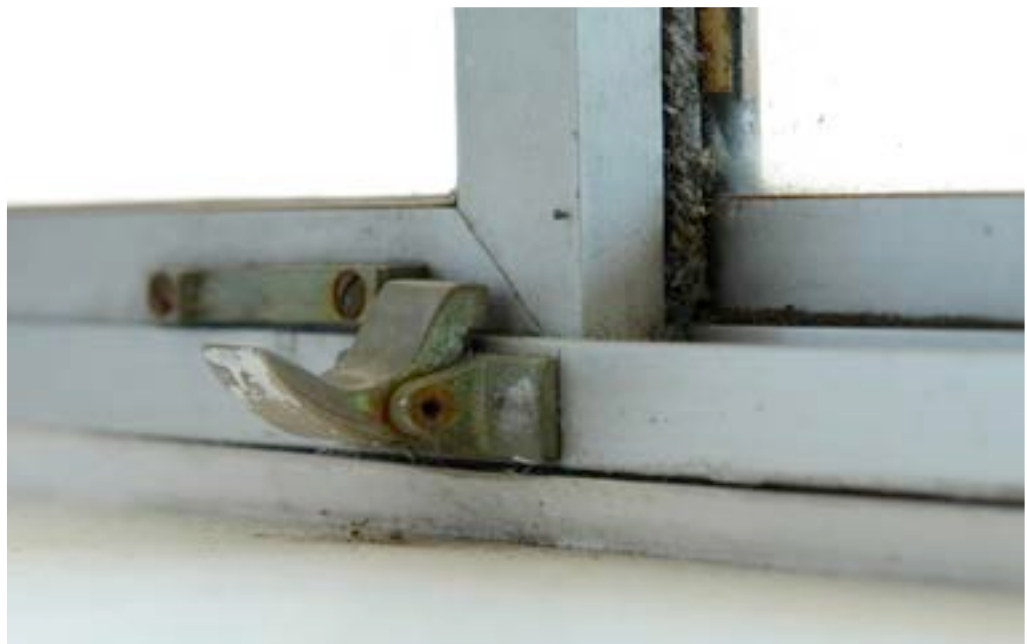
Abb. 40 Verschußbeschlag Schiebefenster
