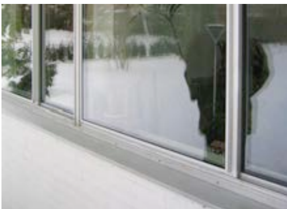
Abb. 54 Schiebefenster m. Stufenisoliertglas Haus Mehrfeld, Walldorf
