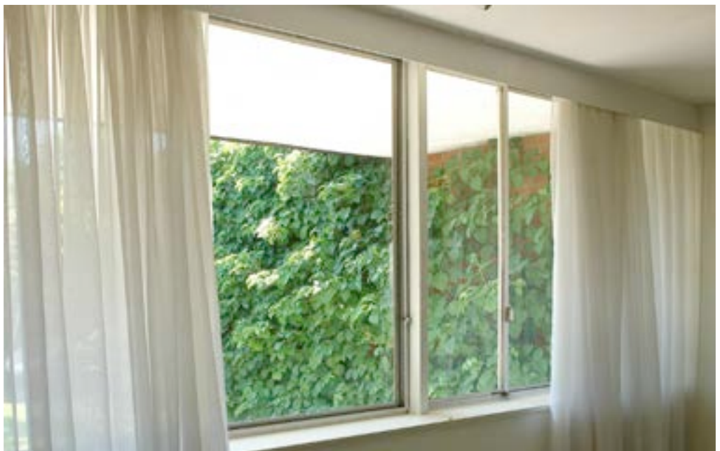
Abb. 39 Innenansicht Schiebefenster, unverändert von 1962, einfach verglast,
