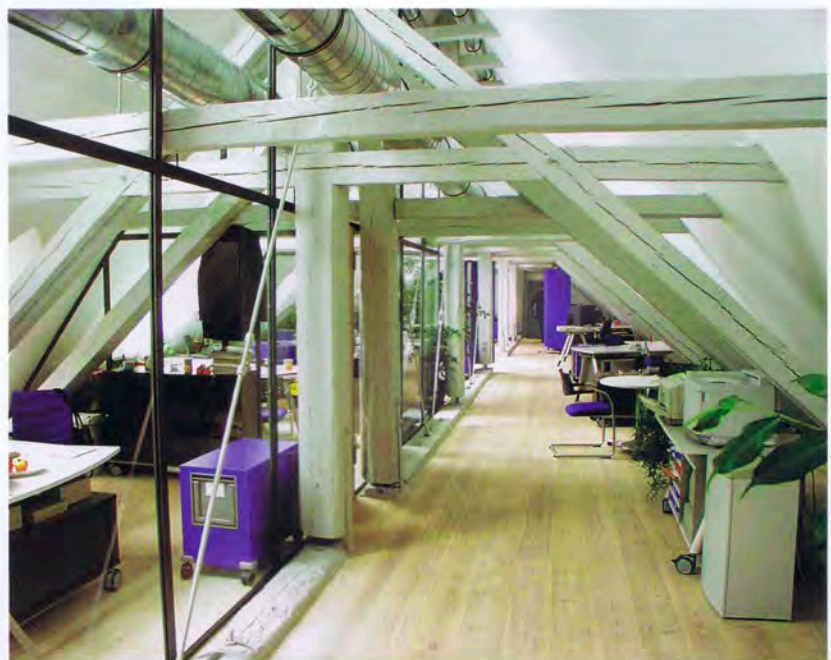
69 Blick in den Dachraum mit neuer Büronutzung.
