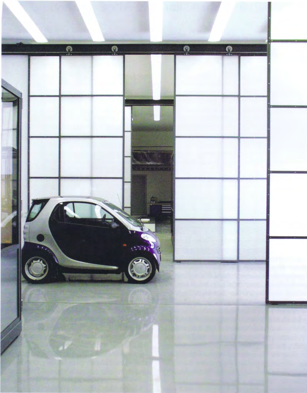
73 Stahl-Schiebeelemente zur Rauntrennung der Arbeits- und Präsentationsbereiche.
