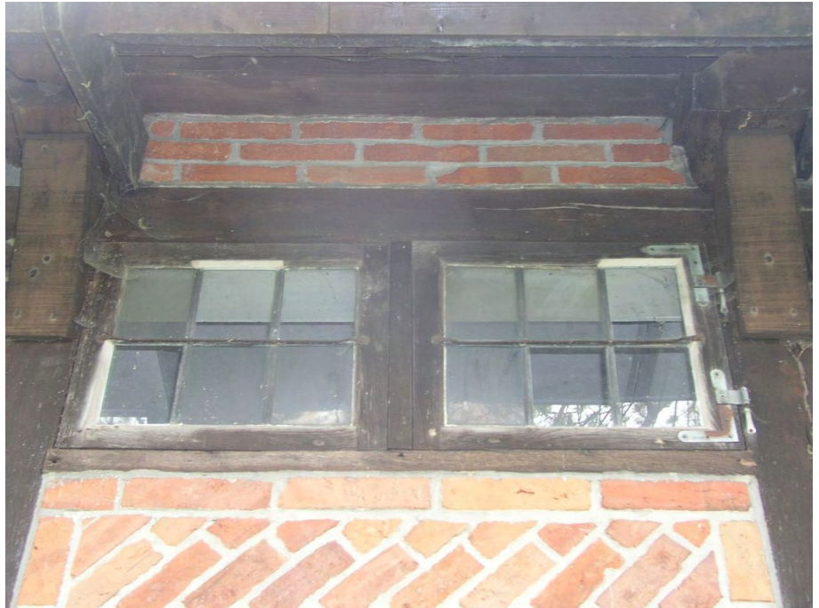
Abb. 42: Fenster NORD IV. Außenansicht mit ergänzten Beschlägen und Reparaturen im Bereich der Einputzungen
