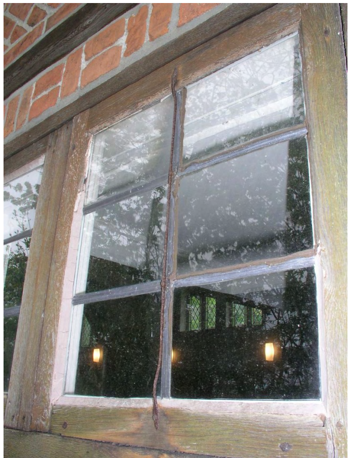
Abb. 41: Saalfenster nord IV mit unsachgemäßen Glasabdichtungen rechts und korrodierter Windstange
