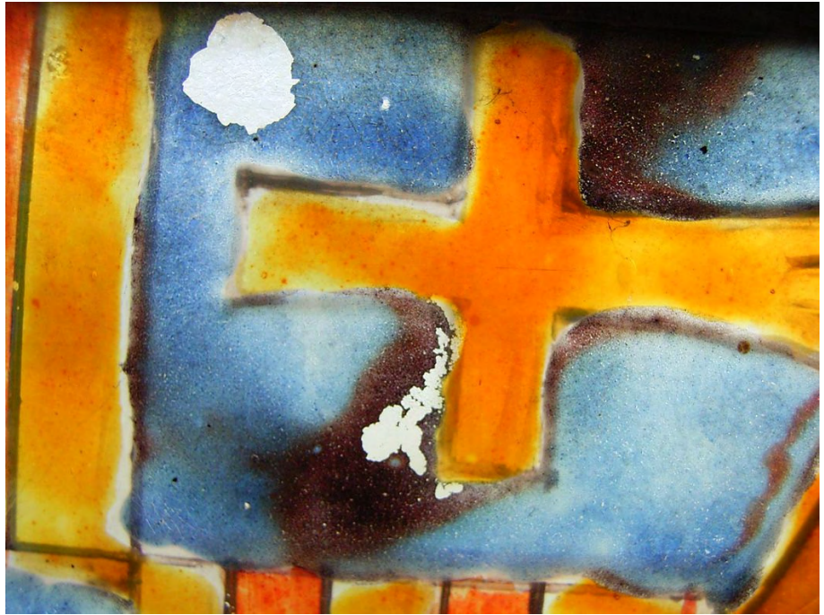
Abb. 30: Detail aus Fenster NORD III,1a mit erkennbaren partiellen Ablösungen insbesondere der blauen Emailfarbe
