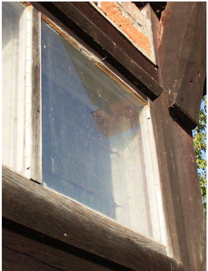
Abb. 43: Äußere Schutzverglasung der Chorfenster mit poröser und teils abgängiger Abdichtung
