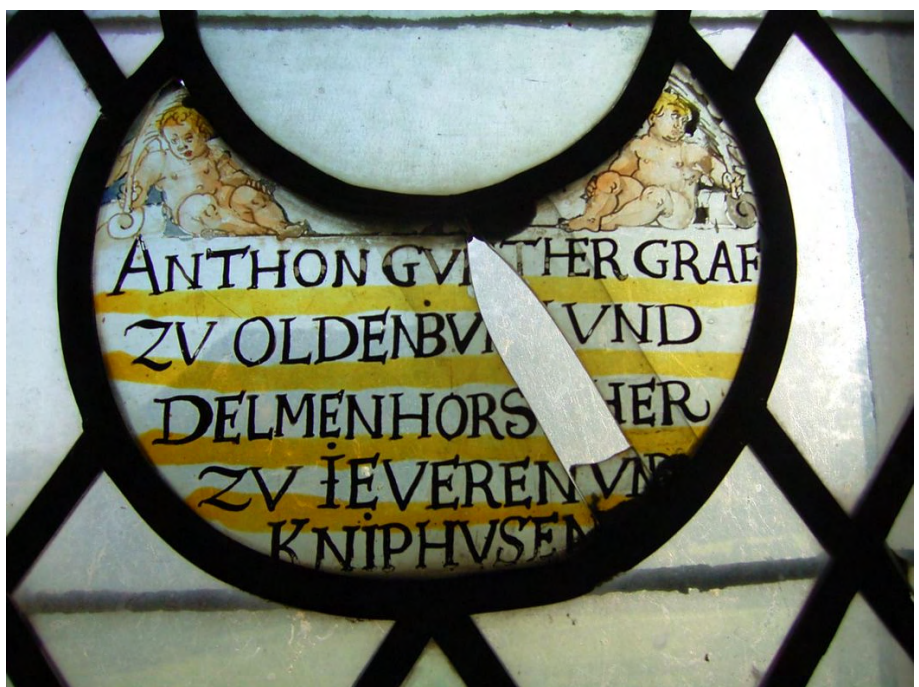
Abb. 25: Detail aus Fenster NORD III,1c mit Fehlstelle im Schriftfeld, rückseitig mit einem Blankglasstück hinterklebt
