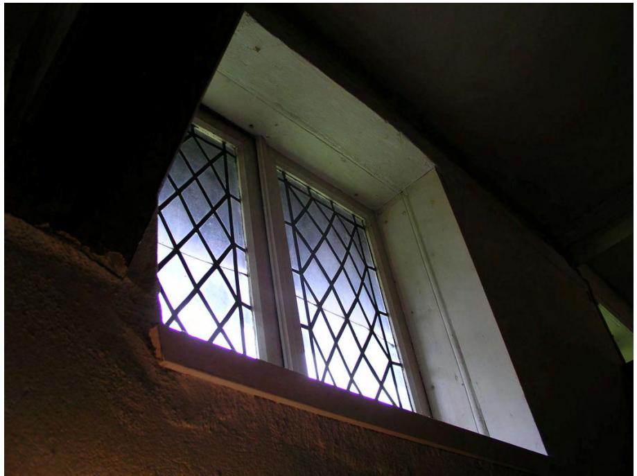
Abb. 40: Saalfenster SÜD VIII. Schrägansicht mit erkennbarer Verformung der Bleinetze
