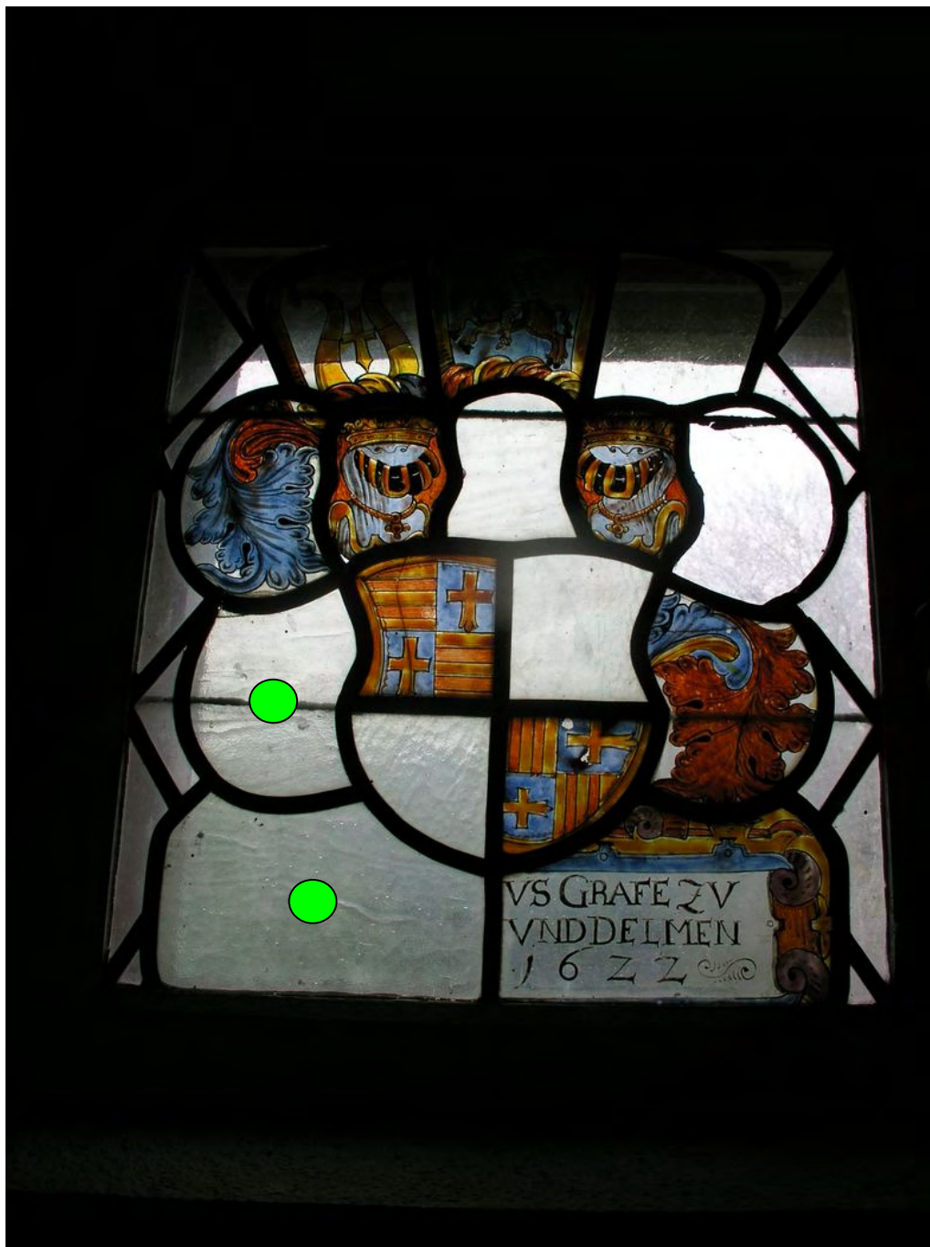
Abb. 37: Fenster NORD III,1a. Heutiger Zustand. Nach Rücksprache mit einem Wappenkundler sind die grün markierten Gläser ggf. in Anlehnung an das Vorbild der erhaltenen rechten Seite der Wappenscheibe mit Ausnahme der Inschrift in Sgraffito-Technik zu ergänzen
