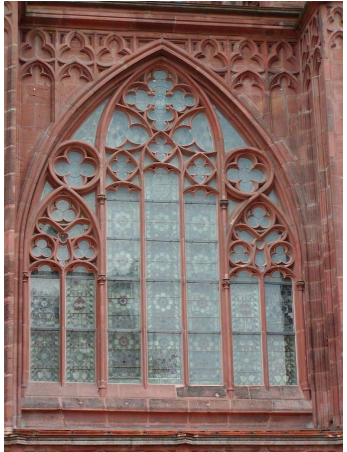
Abb. 68: Oppenheim, Katharinenkirche. Fenster mit einer Schutzverglasung aus maschinengezogenem Goetheglas
