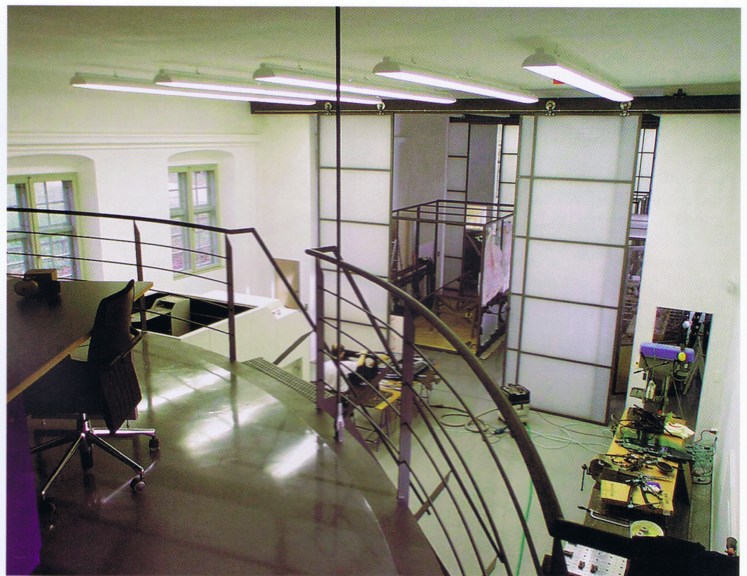
72 Halbbogenförmig in den Raum ragende Stahlgalerie mit angestellter Treppe.
