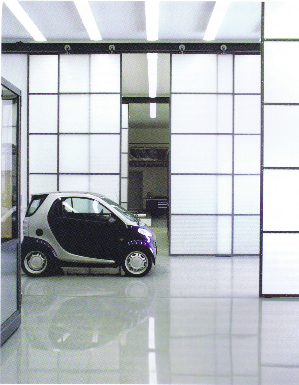
73 Stahl-Schiebeelemente zur Rauntrennung der Arbeits- und Präsentationsbereiche.
