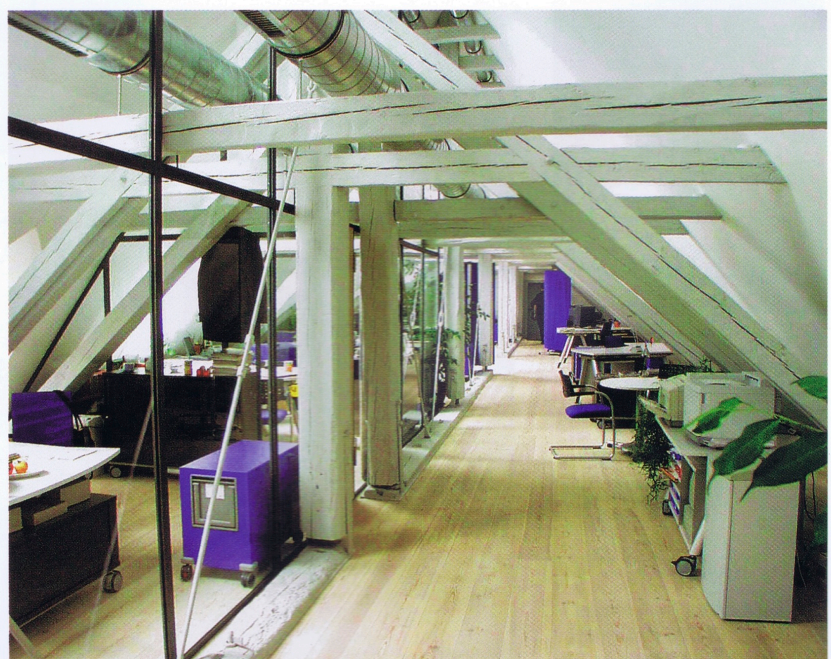
69 Blick in den Dachraum mit neuer Büronutzung.
